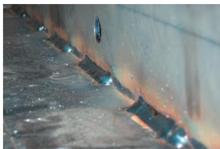
Tratamento de soldaduras angulares
