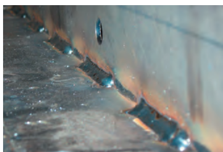
Tratamento de soldaduras angulares
