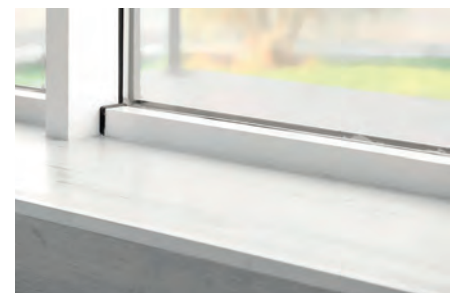
Peitoril de janela e degraus de granito Tratamento de bordas
