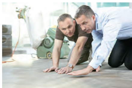
Parquet: lixagem prévia, intermédia e final
