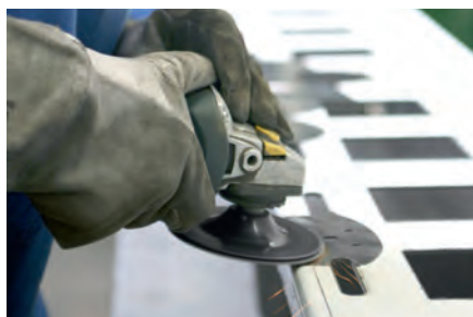
Tratamento de rebarbas de perfuração e de corte
