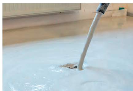
Capa de anhidrita | Lijado plano
