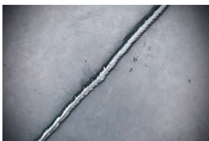
Juntas de soldadura
