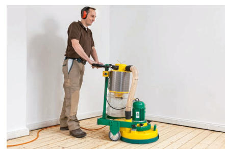
Pre-Lijado y lijado de acabado | Discos abrasivos
